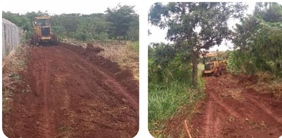
Figura 119 – Manutenção dos aceiros
