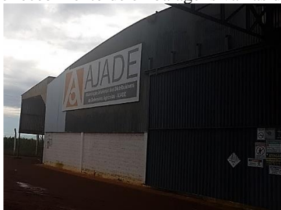
Figura 54 – Galpão de recebimento de embalagens vazias de defensivos agrícolas
