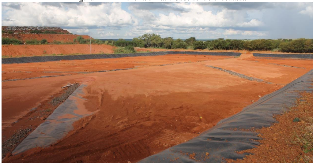
Figura 22 – Trincheira em atividade sendo executada
