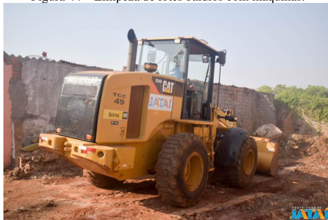
Figura 44 – Limpeza de lotes baldios com máquinas.
