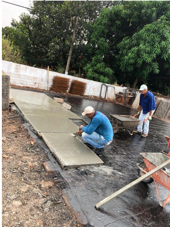
Figura 75 – Serviço de fabricação de tampas de bocas de lobo
