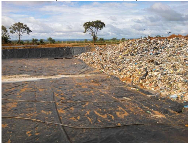
Figura 19 – Trincheira em operação
