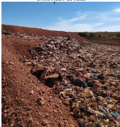
Figura 32 – Trincheira em Operação do Aterro Controlado de Jataí
